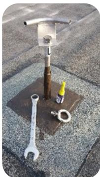
Montage und Ausrichtung der Kurven an allen Eck- und Knickpunkten auf den Systemstützen als Seileckhalter.
