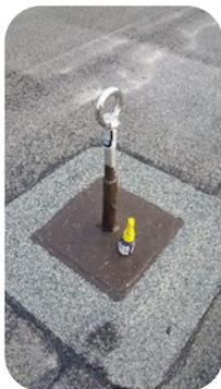
Montage und Ausrichtung der überfahrbaren Zwischenhalter Typ: Zwischenhalter 1 auf den Systemstützen.
