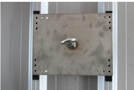
Platzieren Sie die Anschlagereinrichtung wieder auf den Sandwichpaneelen. Bohren Sie ( $\text{Ø } 7,8 \text{ mm}$ ) durch die Dichtung und durch das Deckblech der Sandwichpanelee durch die jeweils 3 passenden Löcher in jeder Ecke der Anschlagereinrichtung.
