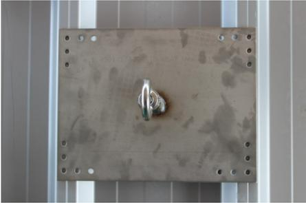
Platzieren Sie die Anschlagereinrichtung an der gewünschten Stelle auf den Sandwichpaneelen.
