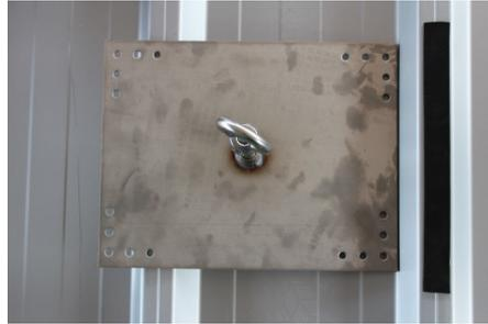
Kleben Sie die mitgelieferte Dichtung im Bereich der Anschlagereinrichtung auf die Hochsicke der Sandwichpanelee.
