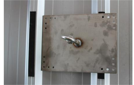
Kleben Sie die zweite mitgelieferte Dichtung im Bereich der Anschlagereinrichtung auf die benachbarte Hochsicke der Sandwichpanelee.
