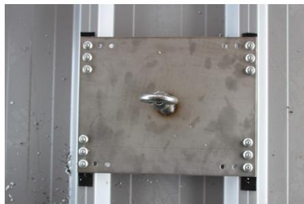
Befestigen Sie die Anschlagereinrichtung mit den 12 mitgelieferten Nieten auf den Sandwichpaneelen.
