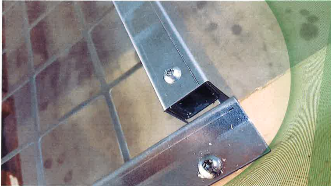
Bild 5: Vierkantröhr zur Verstärkung der Varianten mit RWA
