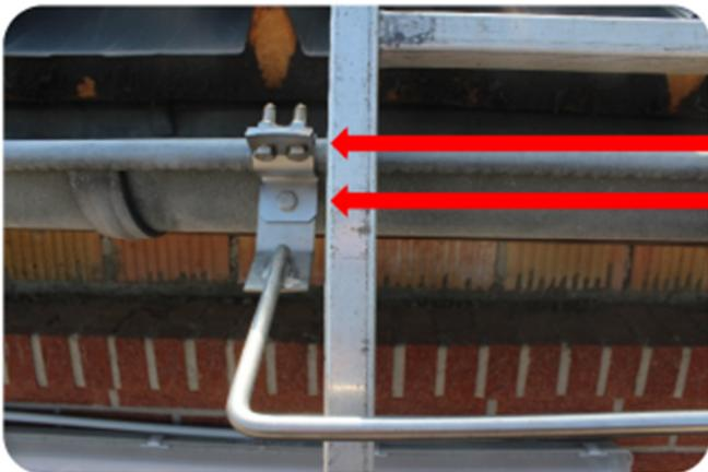
3x Schrauben M8 kontern mit 2x Muttern M8
